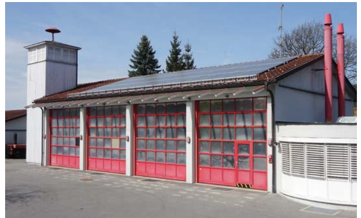
Die Photovoltaikanlage auf dem Feuerwehrhaus wurde mit Beteiligung vieler Bürger ermöglicht.
